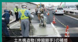
土木構造物(伸縮継手)の補修
