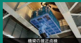
橋梁の接近点検
