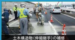
土木構造物（伸縮継手）の補修
