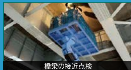
橋梁の接近点検
