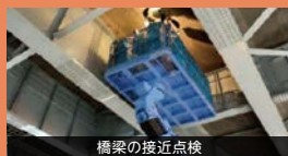
橋梁の接近点検
