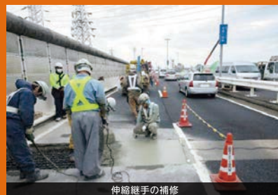
伸縮継手の補修
