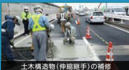
土木構造物(伸縮継手)の補修
