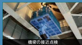
橋梁の接近点検
