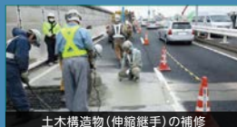
土木構造物（伸縮継手）の補修
