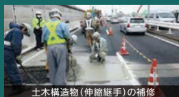
土木構造物（伸縮継手）の補修
