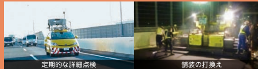
定期的な詳細点検
