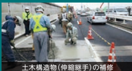
土木構造物(伸縮継手)の補修
