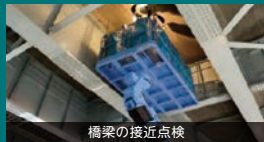
橋梁の接近点検
