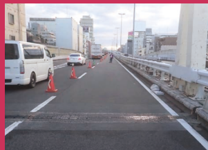
床版連結工事実施前
