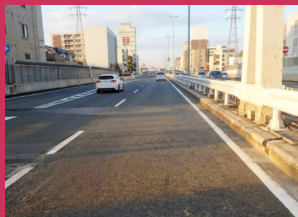
床版連結工事実施後
