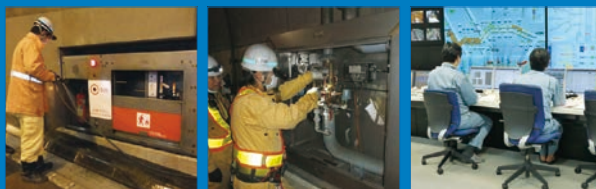
泡消火栓点検
