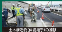
土木構造物(伸縮継手)の補修
