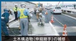
土木構造物（伸縮継手）の補修
