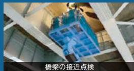
橋梁の接近点検
