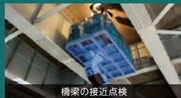
橋梁の接近点検
