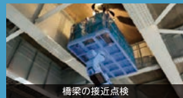
橋梁の接近点検
