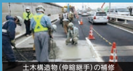
土木構造物(伸縮継手)の補修
