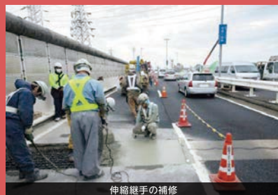
伸縮継手の補修
