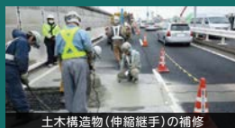
土木構造物(伸縮継手)の補修
