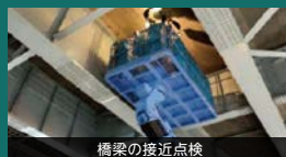
橋梁の接近点検
