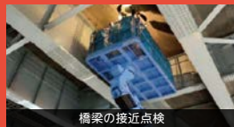
橋梁の接近点検
