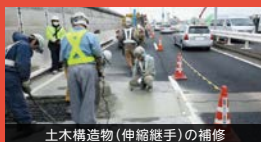
土木構造物(伸縮継手)の補修
