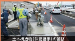
土木構造物(伸縮継手)の補修
